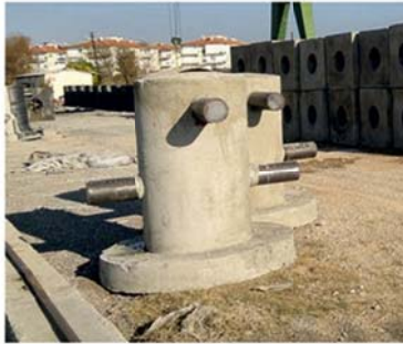
Şekil.3 Koruma Amaçlı Yapay Resif Üniteleri (Özgül vd., 2016)
