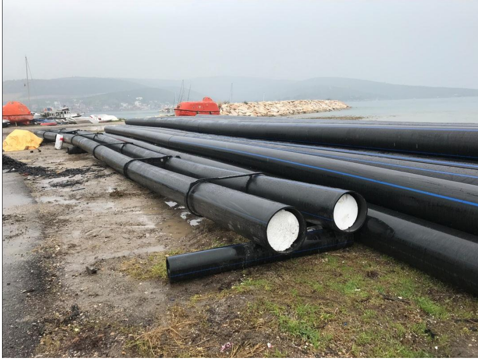
Şekil 16. Kafes yapımında kullanılan yüksek yoğunluklu polietilen borular
