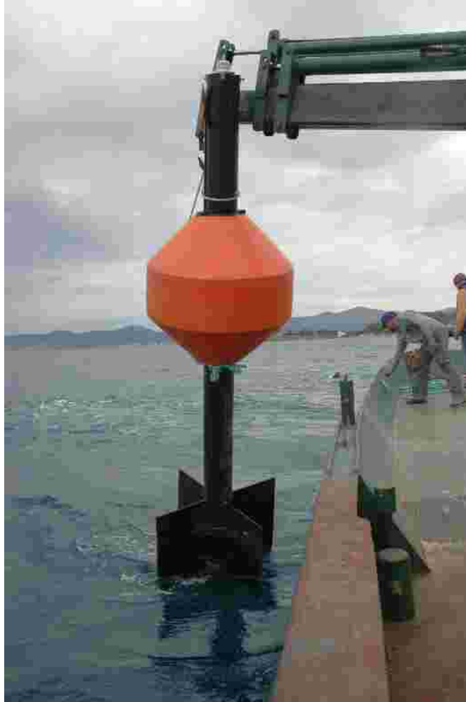
Sekil.7 Yüzen Yapay Resiflerin Yerleştirilme Çalışmaları
