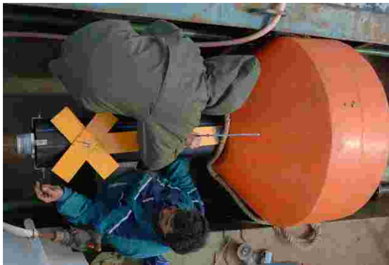
Sekil.4 Yüzen Yapay Resif Üzerindeki Radar Reflektörü ve Çakar Sistemi
